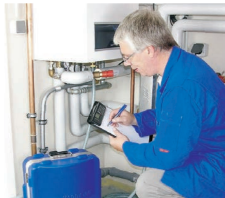
Befüllung mit richtigem Heizungswasser
